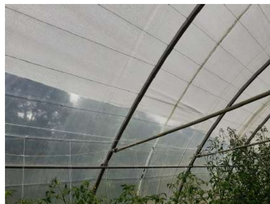
L'installation de voile d'ombrage est une alternative au blanchiment
