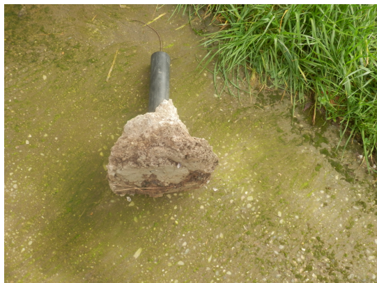
Plot béton pour barre de renfort amovible
